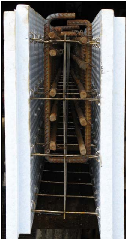
Imagem 2.5.a- Estrutura de reforço utilizada no âmbito dum projecto institucional com vários andares.
