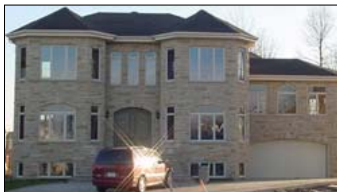
Imagem 5.4.b – Revestimento em pedra
