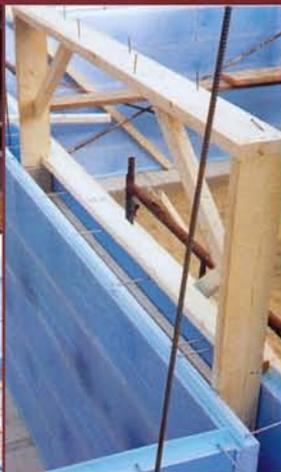
Les 2 panneaux parallèles formant le coffrage isolant sont retenus entre eux par des tiges d'assemblage auxquelles sont fixées les barres d'armature. Les cadres destinés à recevoir les portes et fenêtres sont installés entre les panneaux, avant la coulée du béton.
