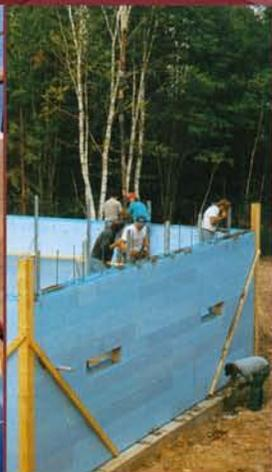
Le coffrage isolant Polycrete® ne nécessite aucun support sur le côté extérieur. Le temps de manipulation et les coûts de matériaux s'en trouvent donc réduits.
