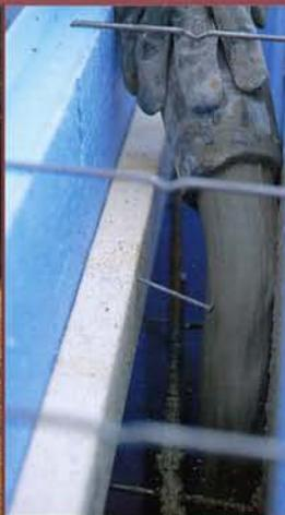
Le béton est coulé à l'intérieur du coffrage isolant par l'entremise d'une pompe à béton. En hiver, la chaleur générée par la prise du béton dans les coffrages isolants suffit pour prévenir le gel et ce, à des températures aussi basses que -22°F (-30°C)
