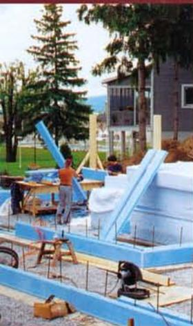
Les panneaux rigides de polystyrène expansé sont ultralégers. Ils se transportent et se manipulent très aisément sur le chantier.
