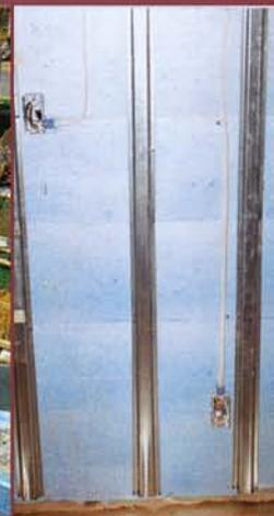
Les "T" de polymère insérés facilitent l'emboîtement des panneaux, l'installation électrique et la finition intérieure et extérieure.
