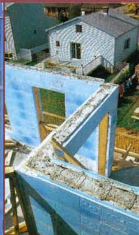
Le béton adhère parfaitement à la paroi, créant ainsi un mur "sandwich". Ce mur porteur possède une résistance de loin supérieure à une structure conventionnelle.
